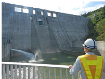
ダム堤体監視
