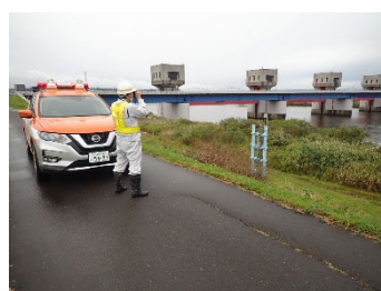
馬淵大堰状況確認
