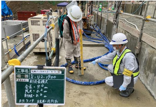
基礎処理工立会（グラウト削孔長）
